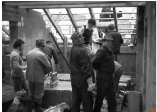
Gerätehaus an der alten Schule
